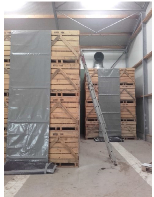
Stockage des échalotes en caisses palettes et son système de ventilation par aspiration (Photo CA BZH)
